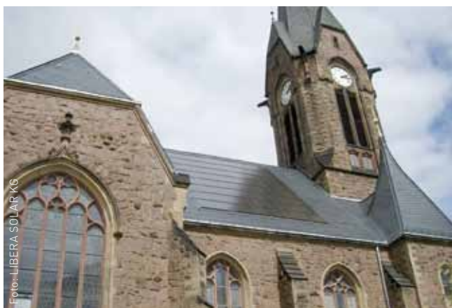
Die Lutherkirche in Meissen mit einer Indach-Photovoltaikanlage auf dem Mittelschiff
