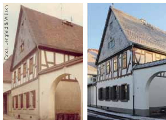
Energetische Sanierung in Wiesbaden – vor und nach der Sanierung
