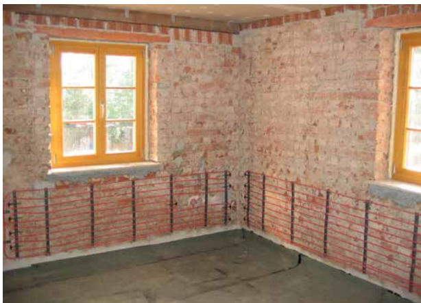
Abb. 77 Einbau einer Wandheizung vor Ziegelmauerwerk
