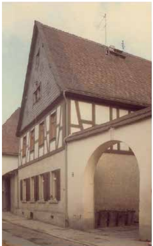
Abb. 6 Am Schloßpark – vor der Sanierung
