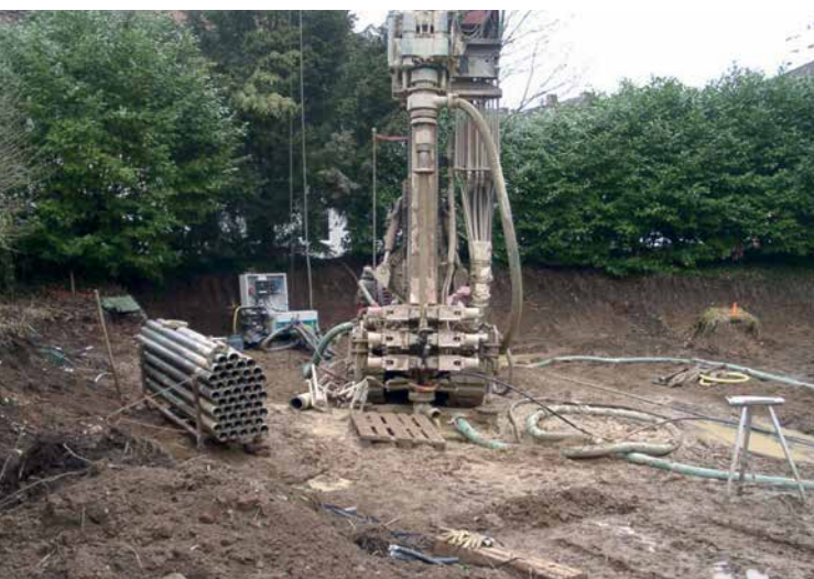
Abb. 74 Erdbohrung für eine Wärmepumpe
