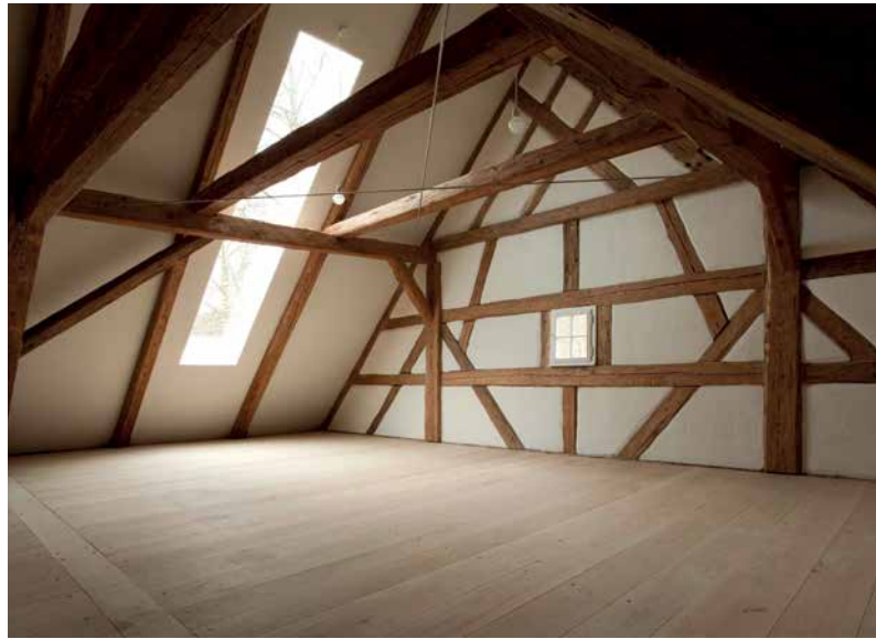
Abb. 25 Sanierung eines Dachwerks mit Aufsparrendämmung und Ausbau zum Wohnraum
