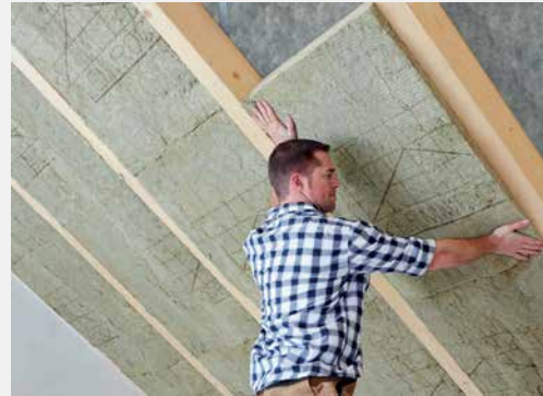
Abb. 20 Einbringen der Dämmung von innen
