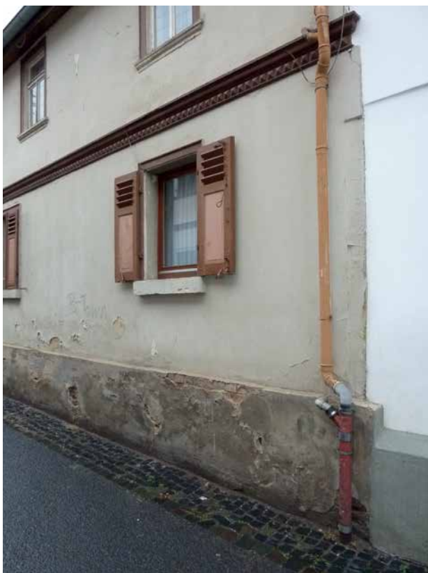
Abb. 64 Schadhafte, durchfeuchtete Außenwand
