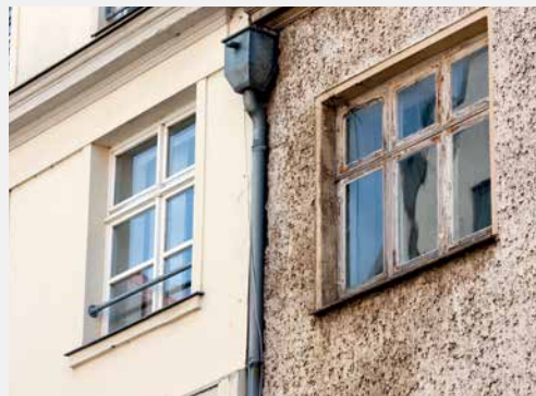
Abb. 51 Restaurierung eines historischen Fensters
