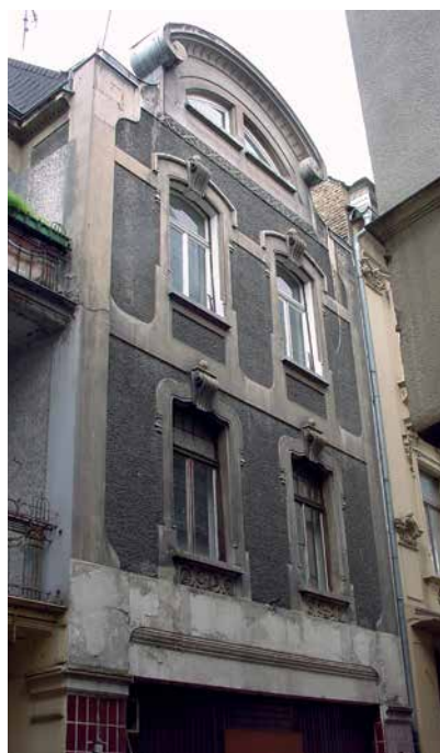
Abb. 92 Kleine Schwalbacher Straße 14 – Straßenseite vor der Sanierung
