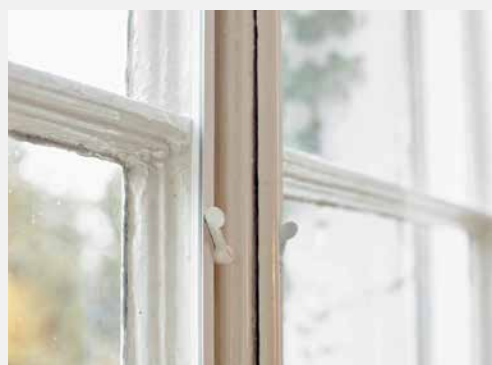
Abb. 52 Ergänzung des Fensters mit Vorsatzschiebe
