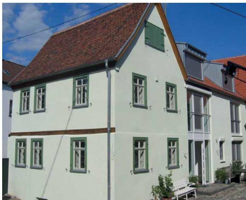
Abb. 101 Hofreite Stolberger Straße – Vor der Sanierung
