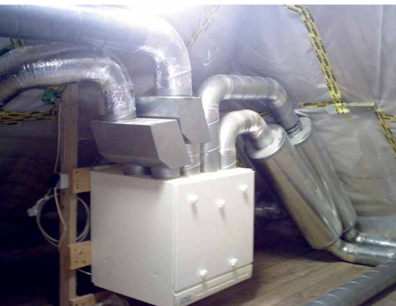
Abb. 86 Komfortlüftung Außenluft und Fortluft über das Dach
