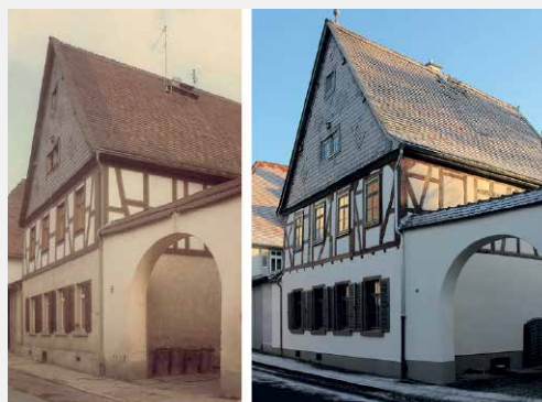
Abb. 44 Am Schloßpark – vor und nach der Sanierung
