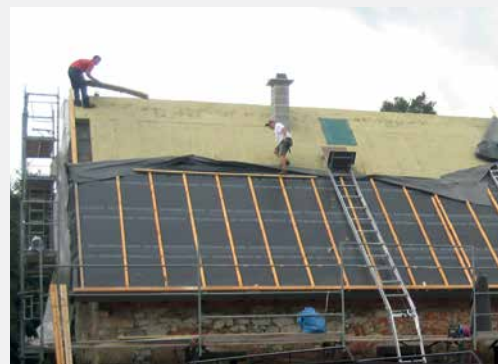
Abb. 21 Dachdämmung von außen
