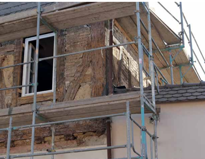
Abb. 99 Am Schloßpark – Vor und nach der Sanierung
