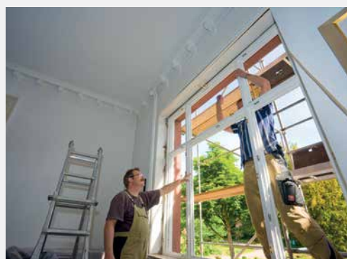
Abb. 53 Nachbau eines Fensters nach historischem Vorbild (Energetische Sanierungsmaßnahme gefördert durch den Innovations- und Klimaschutzfonds der ESWE Versorgungs AG)
