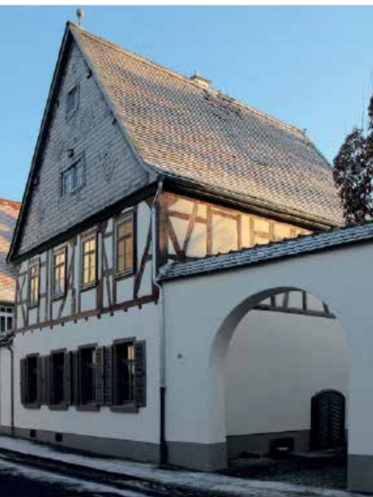
Abb. 7 Am Schloßpark – nach der Sanierung
