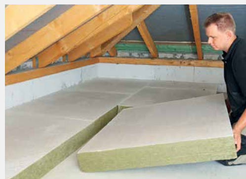
Abb. 22 Dämmung der obersten Geschossdecke
