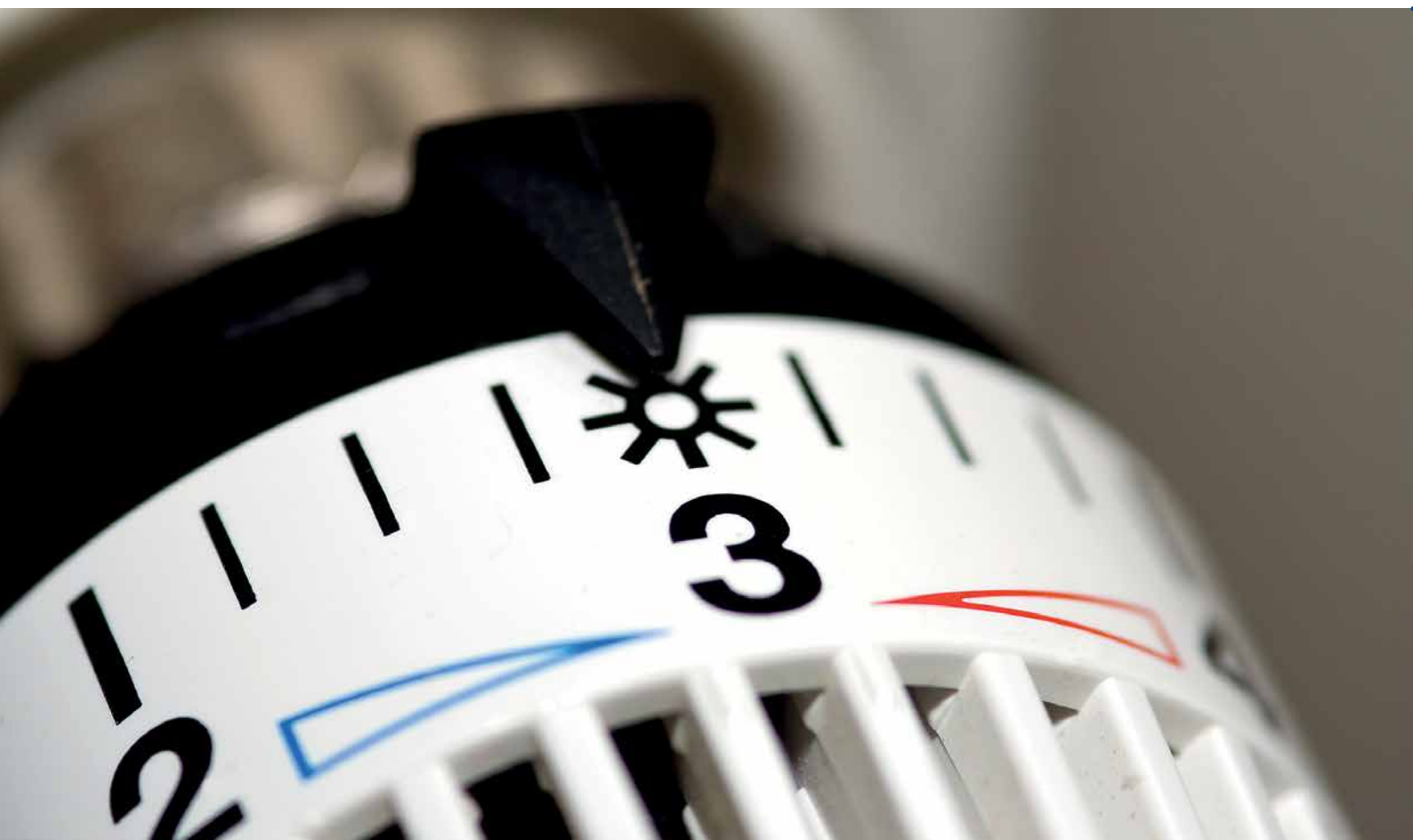
Abb. 59 Der Austausch von Thermostatköpfen kann bereits einen großen Effekt mit sich bringen.
