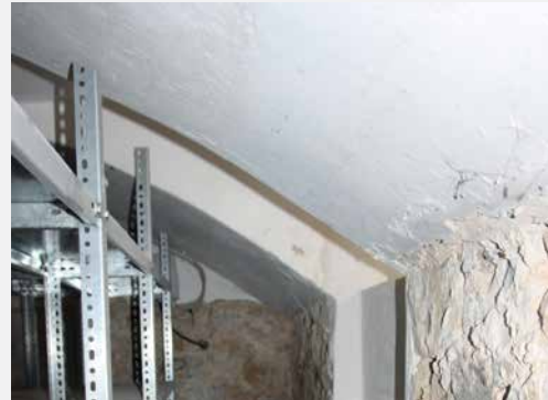
Abb. 31 Flaches Kellergewölbe
