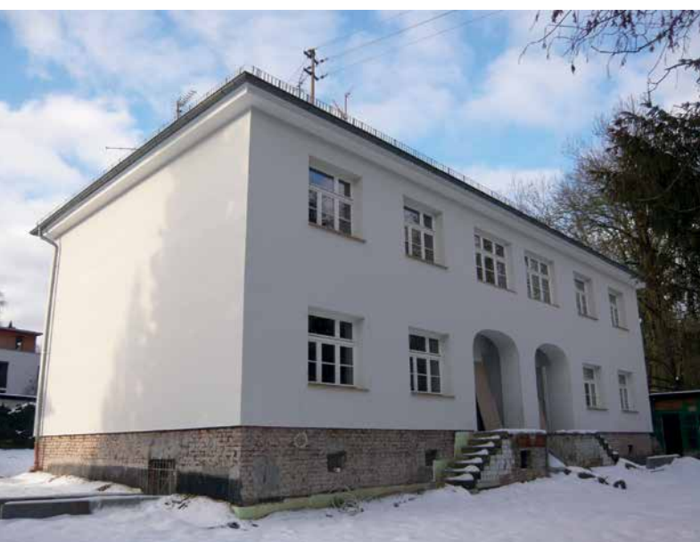
Abb. 95 Adlerstraße – Vor der Sanierung
