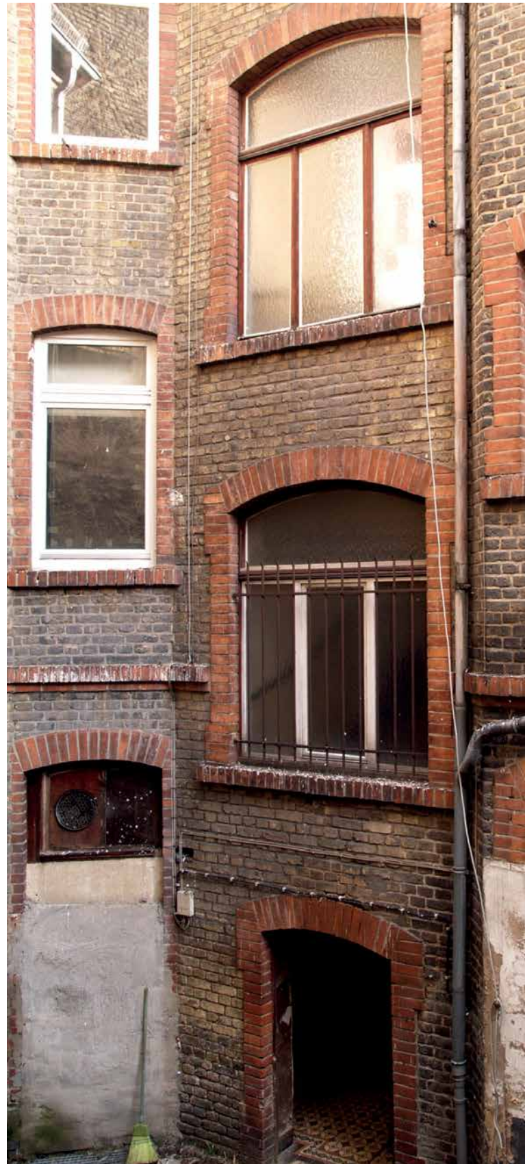
Abb. 18 Kleine Schwalbacher Straße – Beispiel einer Hoffassade
