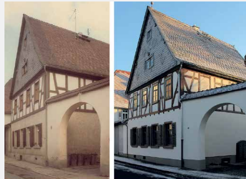
Abb. 11 Am Schloßpark – vor und nach der Sanierung
