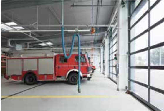
Fahrzeughalle mit 7 °C im Winter
